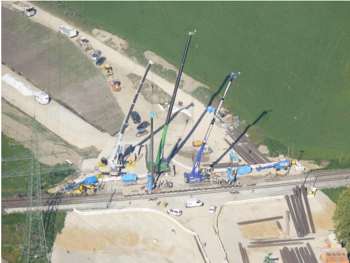
Luftbild vom 30.6.2019: Einbringen der Spundwandsicherung (Copyright: Schellmoser)
