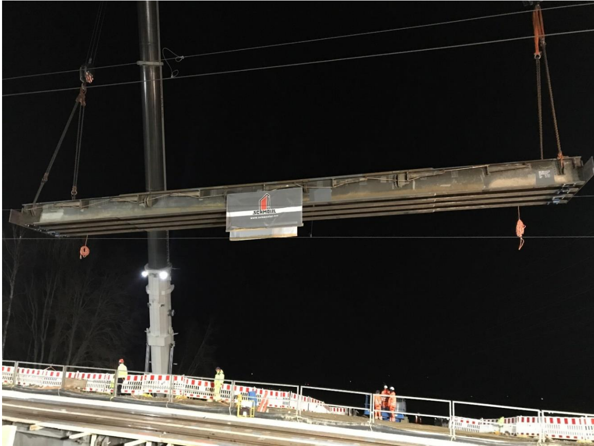
Aufnahme vom November 2020: Einhub der 2. Behelfsbrücke
