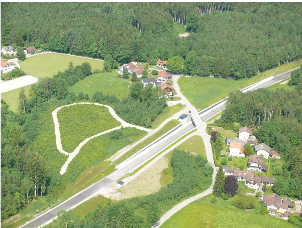
Bauabschnitt 3.1: Luftbild vom Juni 2023 des Lärmschuttrogs Großholzstraße (Foto: Schellmoser)
